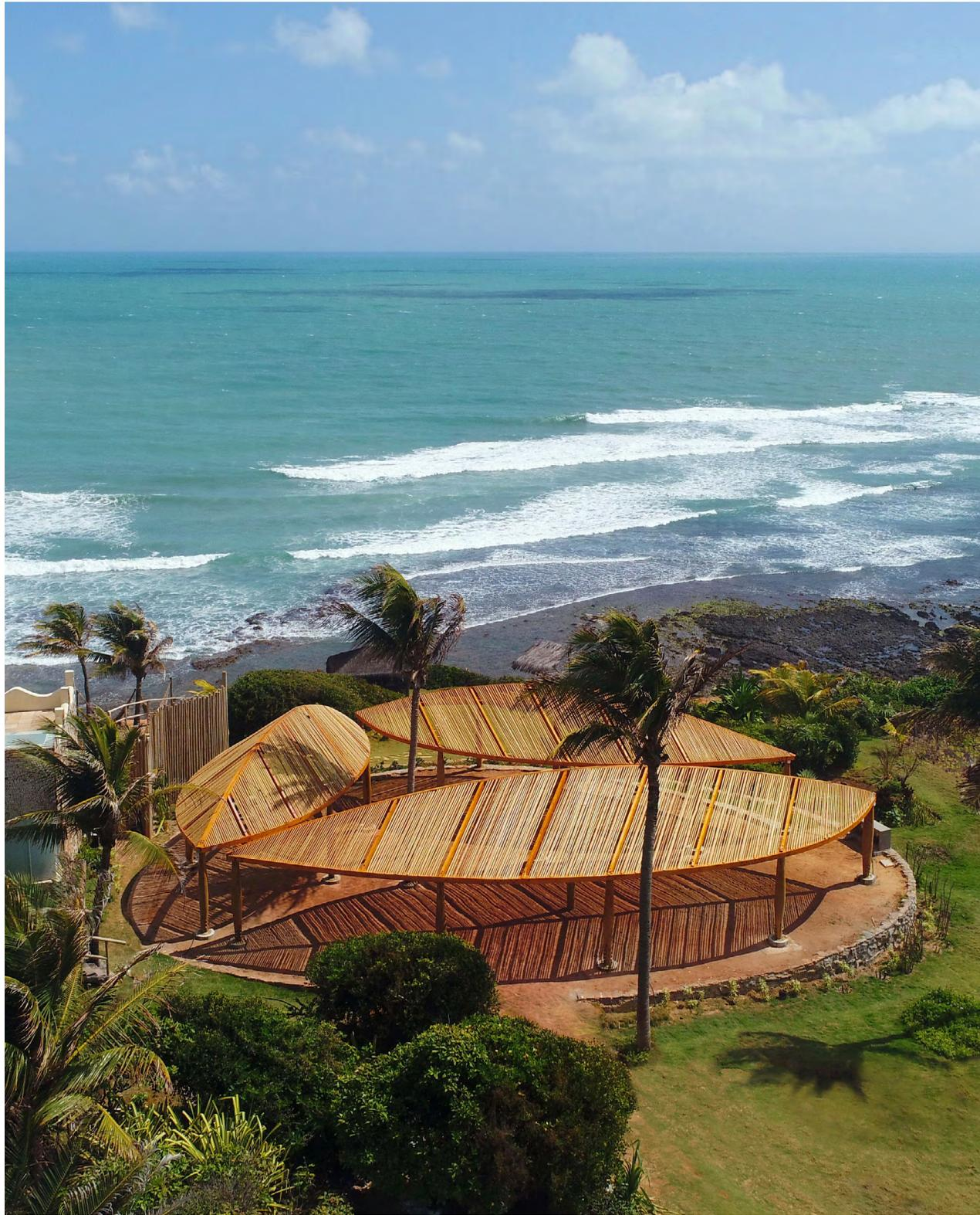
IL FOLHA'S SAGRADAS È IL PADIGLIONE DELL'HOTEL KILOMBO SULLA PRAIA DE SIBAÚMA (NORD-EST DEL BRASILE). FIRMATO COME LA GUTTER HOUSE DALL'ATELIER DI DANIEL FLOREZ, È IN LEGNO LAMELLARE E BAMBÙ CON UN TETTO IN POLICARBONATO: I RAGGI SOLARI CHE FILTRANO PROIETTANO SUL TERRENO LA FORMA DI TRE FOGLIE.
